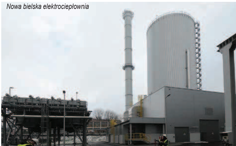
Nowa bielska elektrociepłownia
